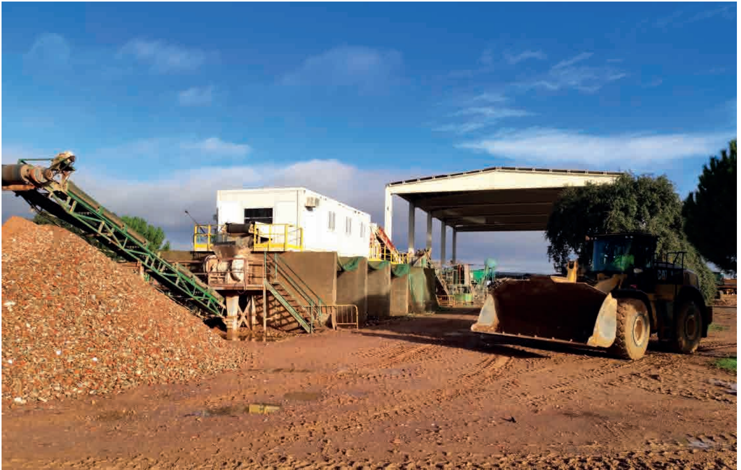
Planta de valorización de residuos de construcción y demolición donde se obtienen áridos reciclados que se utilizan en nuevas obras.
